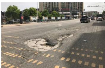
图 3-68 破损路面
