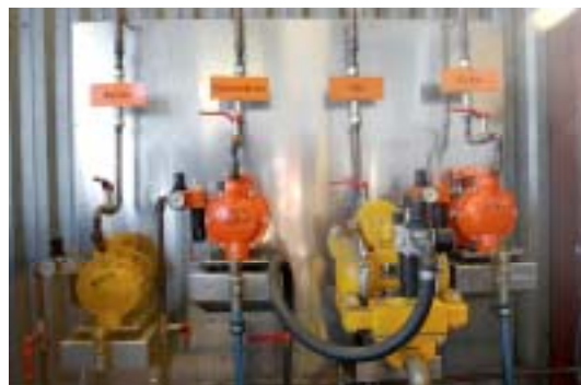
图 1 液体抽取设备(抽取液体包括汽油、柴油、变速器油、发动机机油等)
